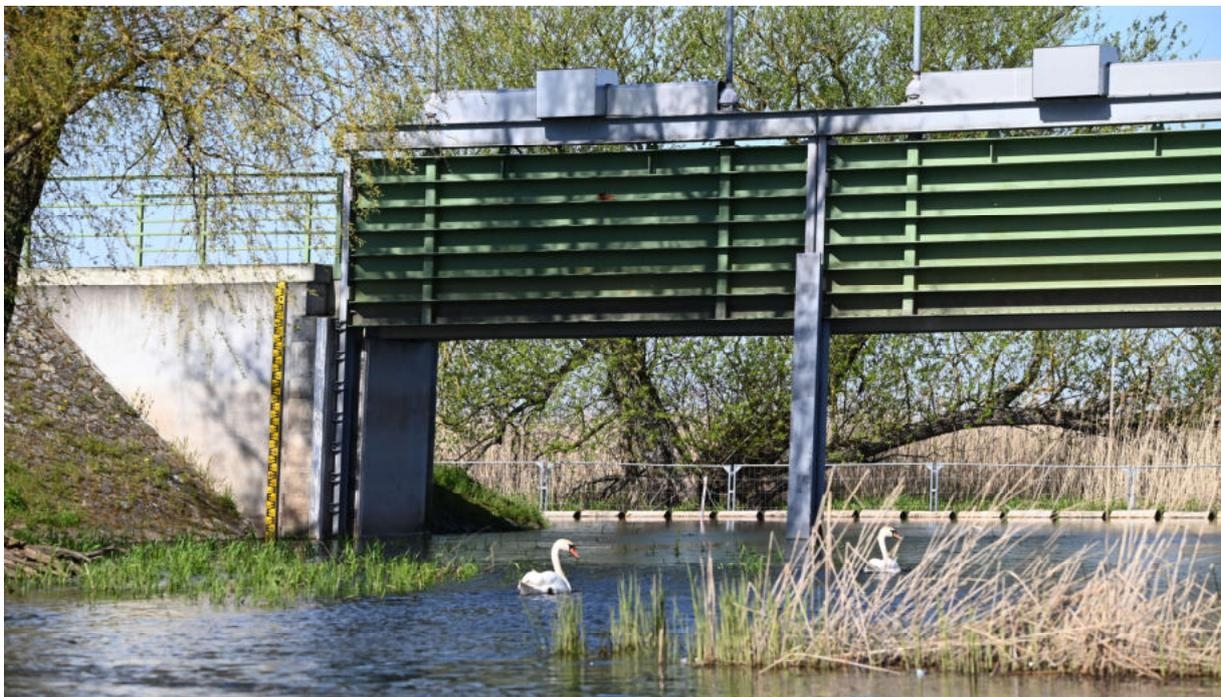
Über Einlassbauwerke wird der Wasserhaushalt in der Oder-Aue reguliert. Foto: Milena Kreiling
