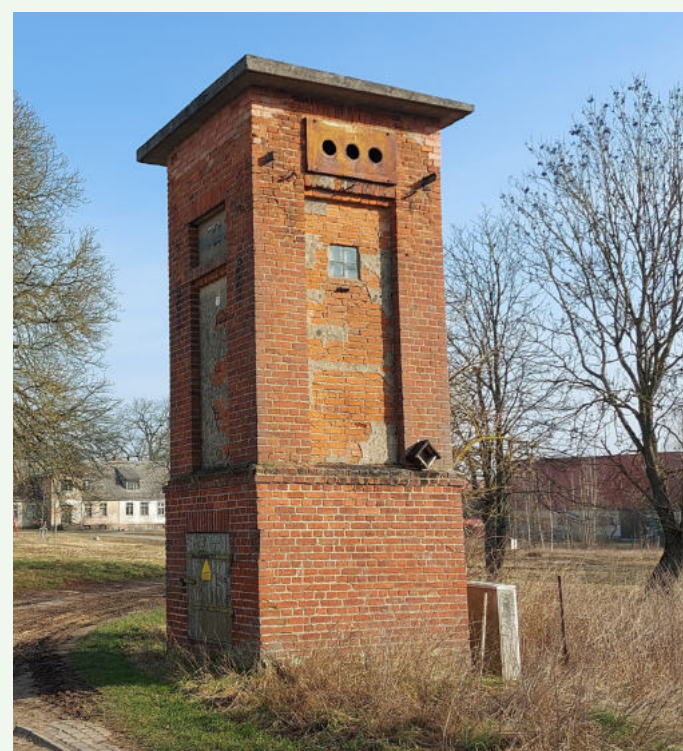
Gebäude wie das Trafohaus können Artenschutztürme werden.
