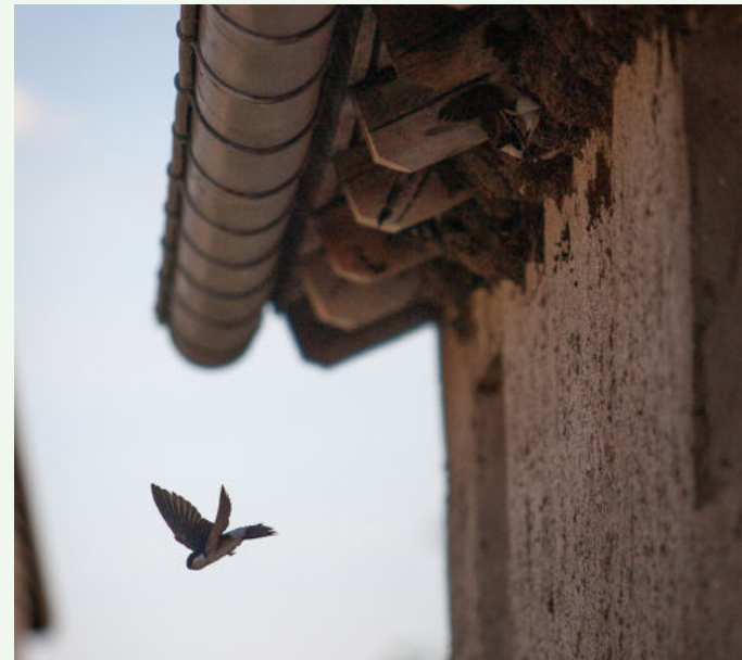
Hauswände und Dachvorsprünge ersetzen natürliche Felsstrukturen.
