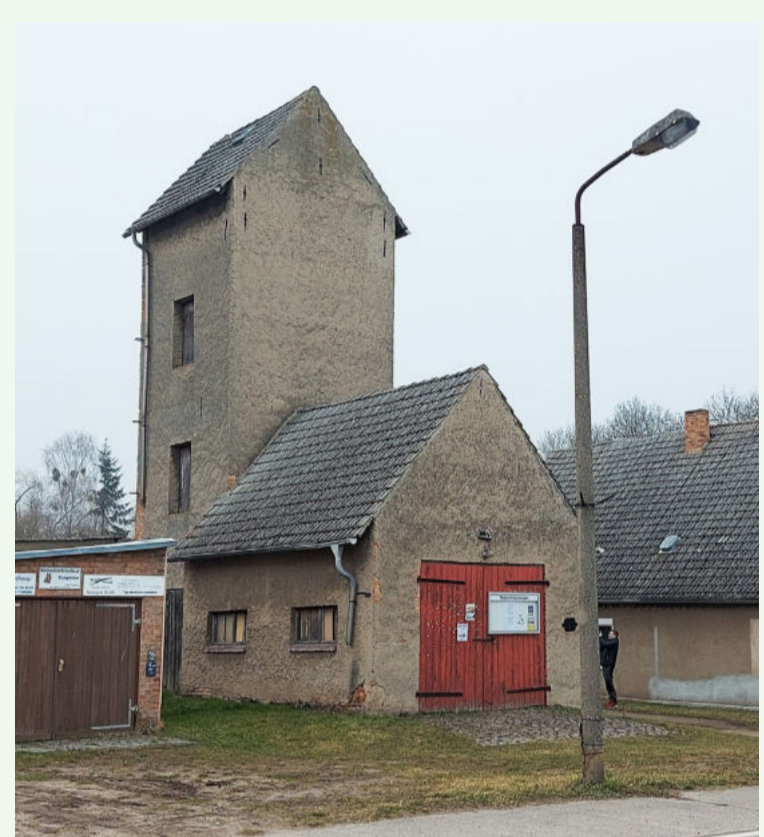
Gebäude wie der Schlauchturm können Artenschutztürme werden.
